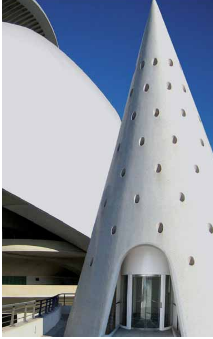
Ciudad de las Ciencias. Valencia. Ascensor hidráulico circular. Pistón enterrado. 800 kg. Altura: 2 paradas. City of Arts and Sciences, Valencia_Hydraulic circular lift. Buried jack. 800 kg. Height: 2 stops.
