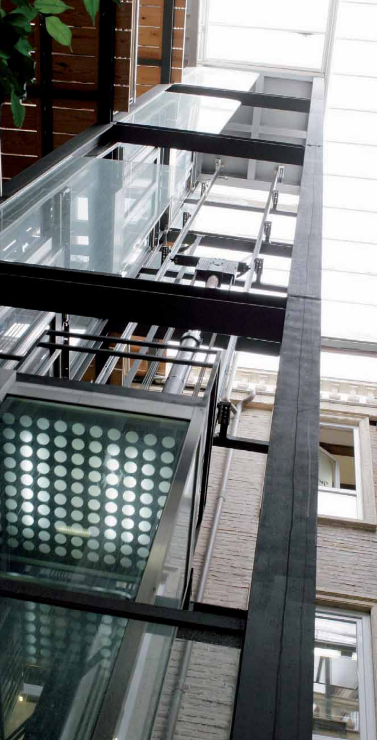
Edificio de oficinas. Puerto de Valencia_ Ascensor hidráulico 600 kg. Altura: 8 paradas. Office building. Port of Valencia. 600 kg. Hydraulic lift. Height: 8 stops.
