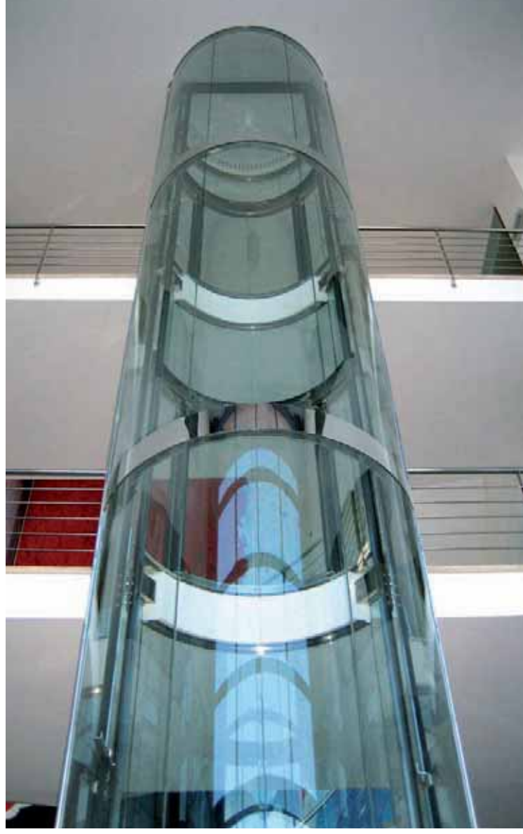
Edificio de oficinas de Constructora. Palma de Mallorca_ Ascensor hidráulico circular 600 kg. Pistón enterrado. Altura: 4 paradas. Constructora office building. Palma de Mallorca_600 kg. circular hydraulic lift. Buried jack. Height: 4 stops.
