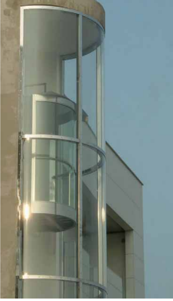
Panorámico en hotel. Italia. Panoramic lift in hotel, Italy.
